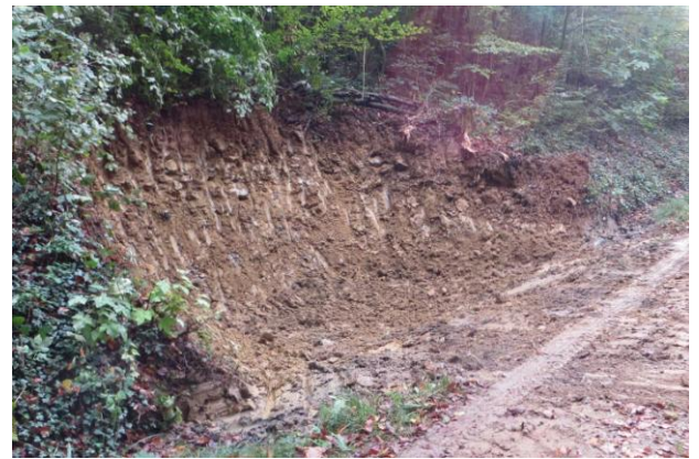
November: Der Graben wird an zwei Stellen verbreitert
